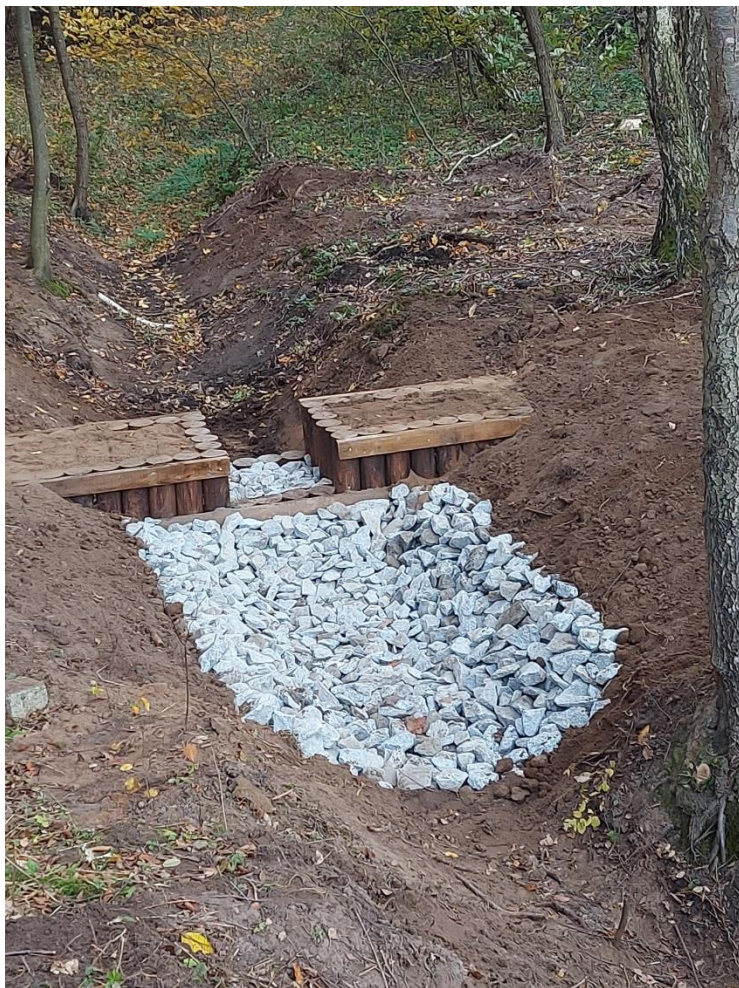
Fot. 7 Nadleśnictwo Lipka zastawka palisadowa H do 0,4m
