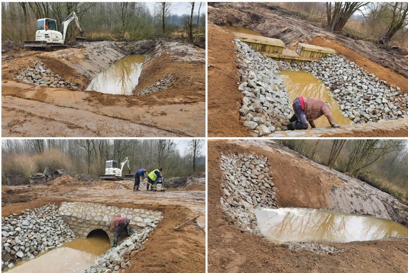
Fot. 4 Nadleśnictwo Okonek - przepust i zastawka na rowie obiekt 4.1
