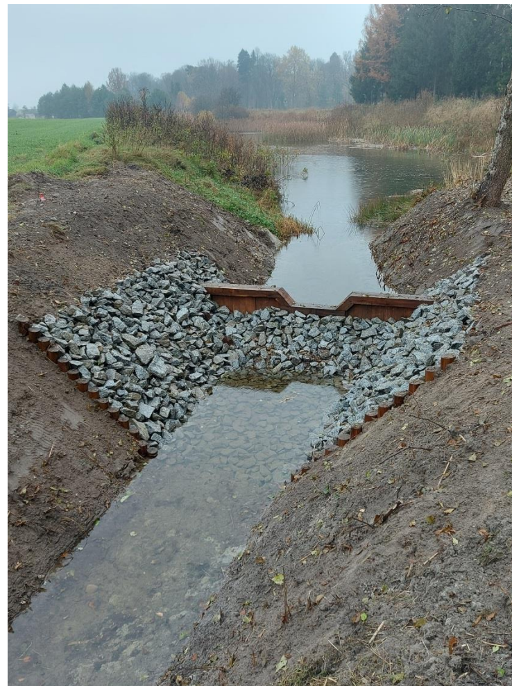
Fot. 8 Nadleśnictwo Lipka zastawka ścianka szczelna H>0,6m
